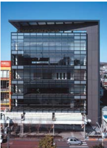
HULIC Hachioji Bldg
